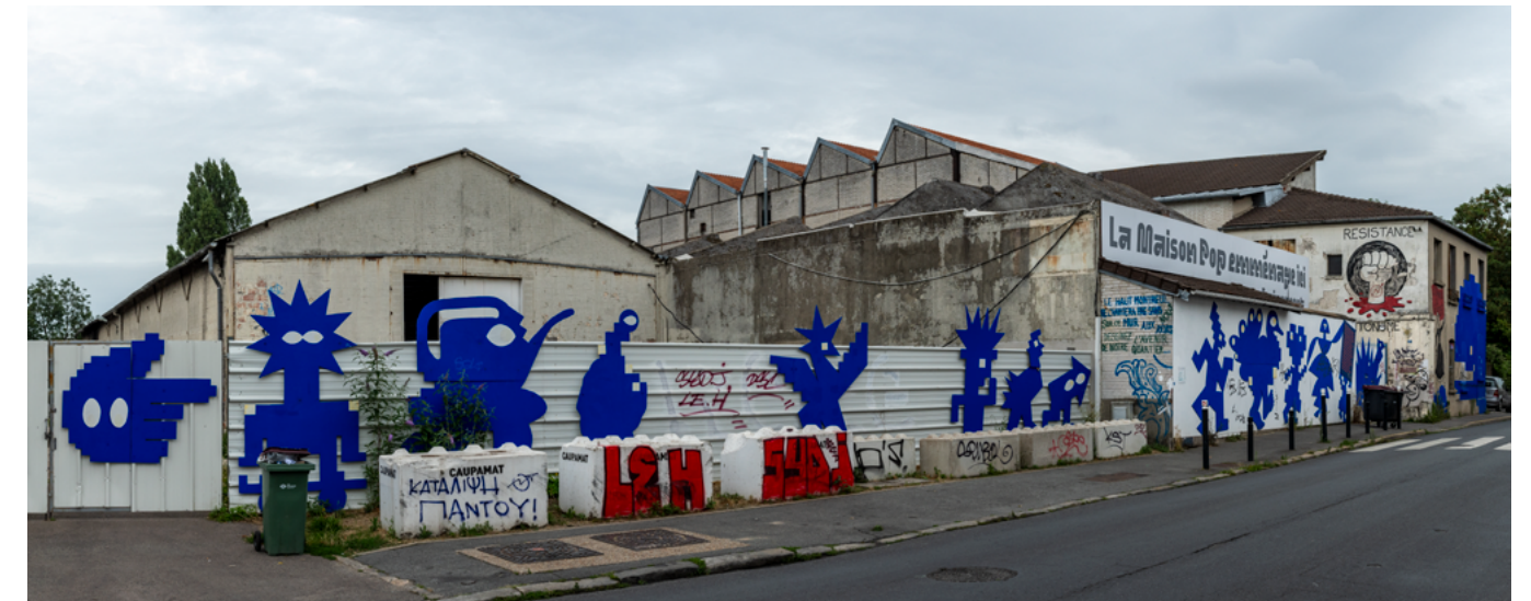
L'usine EIF est en cours de dépollution depuis 2023 et devrait accueillir la Maison Populaire
